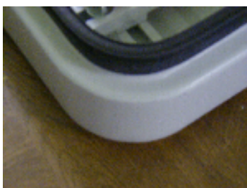
Doppelkantung für Wasserzvangsablauf
